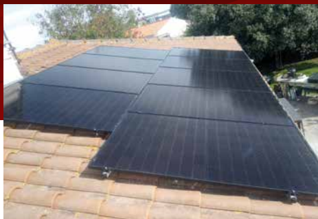
Pose de panneaux photovoltaïques
